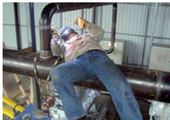
Foto 6.4 Pruebas para soldadura a tope
