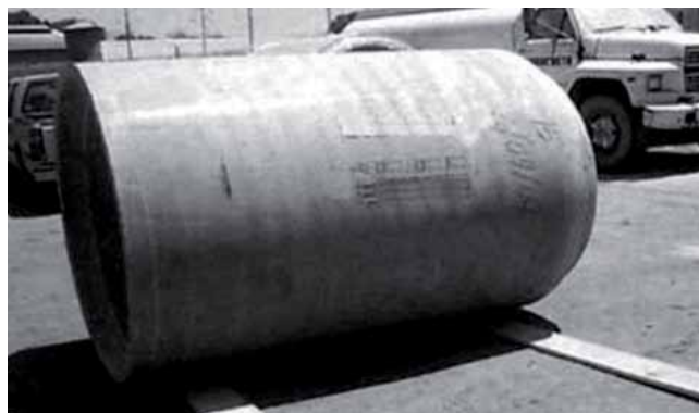
Foto 5.5 y 5.6 Rodamiento de tubo
