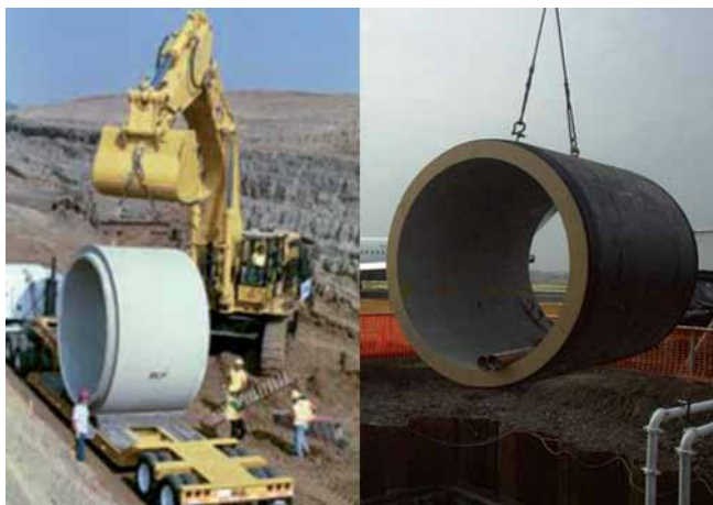
Foto 5.3 y 5.4 Ejemplos de levante de tubería.
