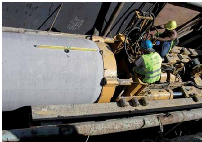
Figura 5.8 Ejemplo de Construcción Hincado de Tubería
