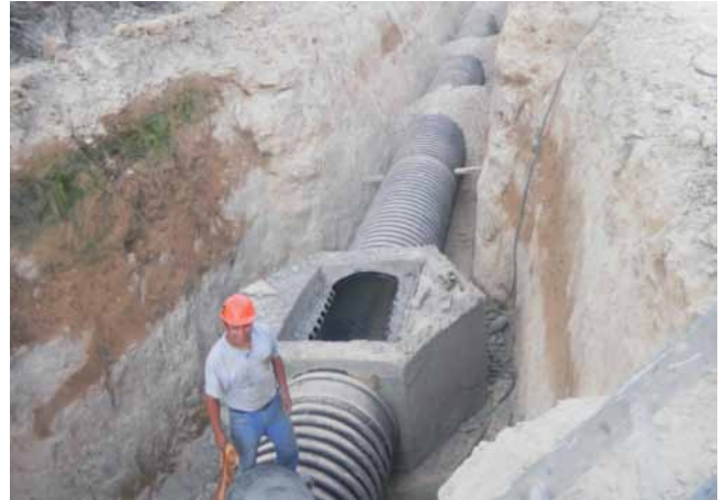
Foto 8.9 Tramo de tubería a ser probado
