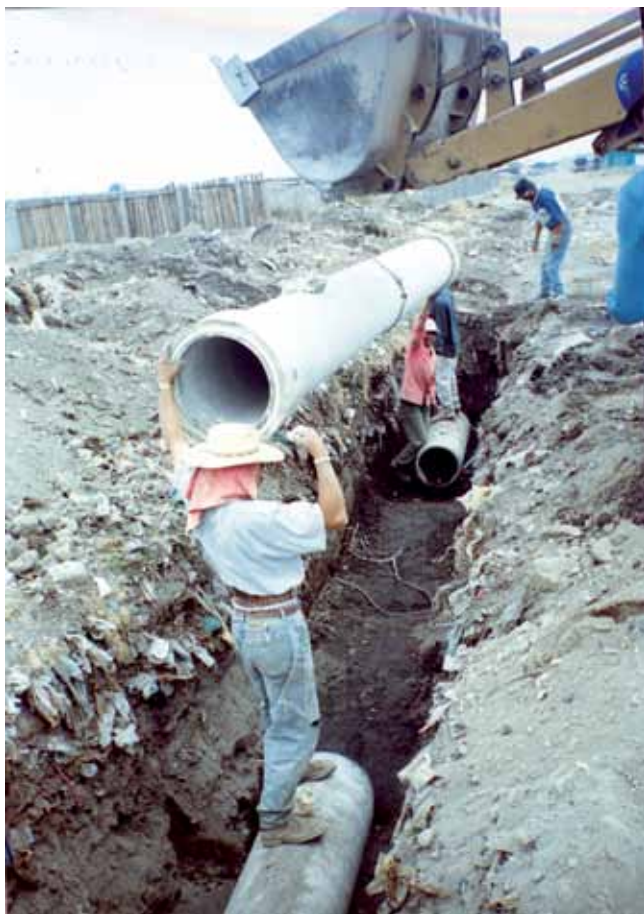
Foto 2.9 Descenso de tubos a la zanja con equipo mecánico
