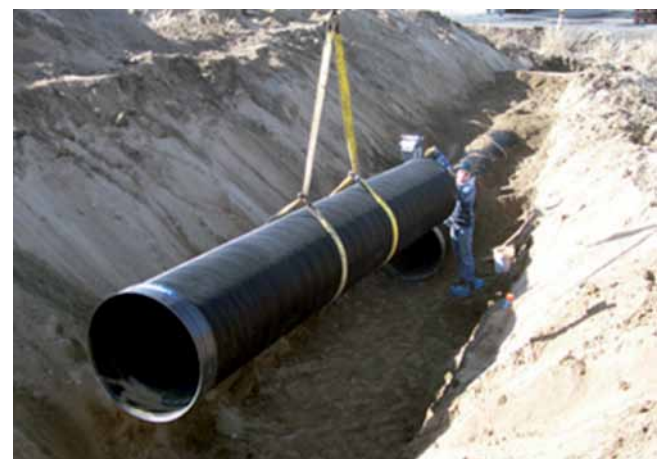
Foto 8.1 Descarga correcta
