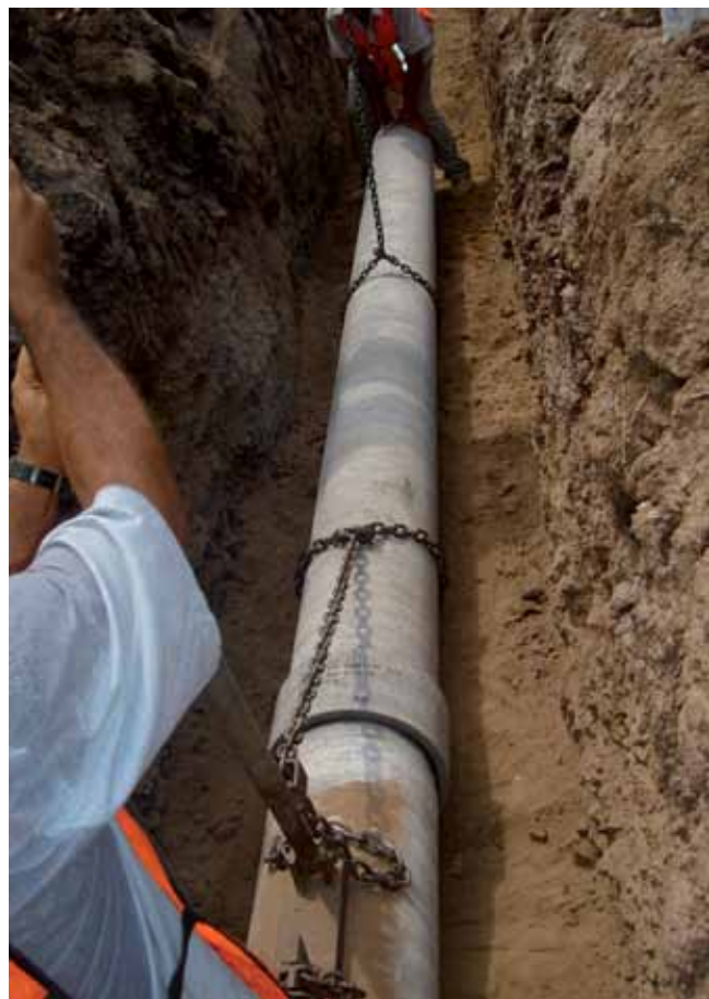
Foto 2.10 Encampanado dentro de zanja
