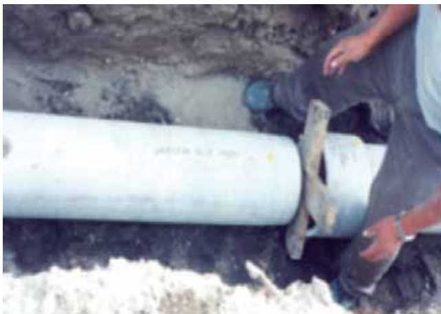
Foto 2.13 Colocación de cruceta de madera para enchufe de cople a tubo
