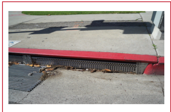
Ilustración 6.40 Coladera combinada desfasada
