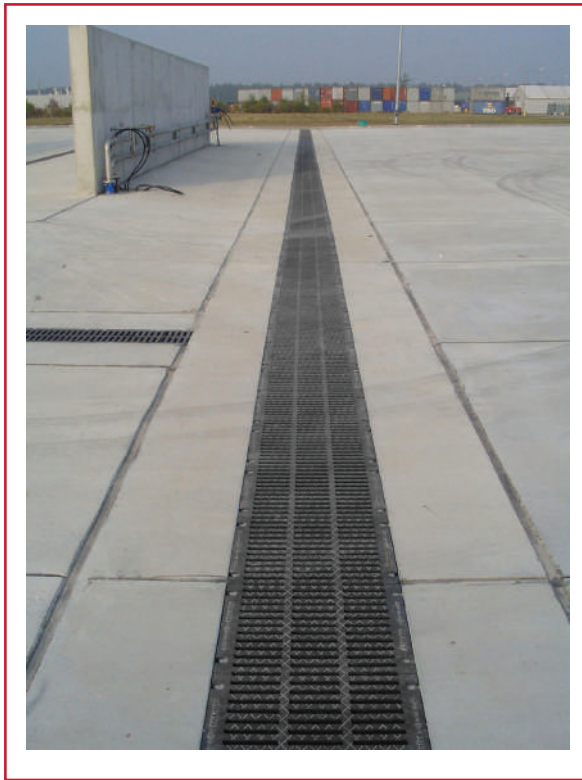
Ilustración 6.38 Rejilla de ingreso en coladera de piso
